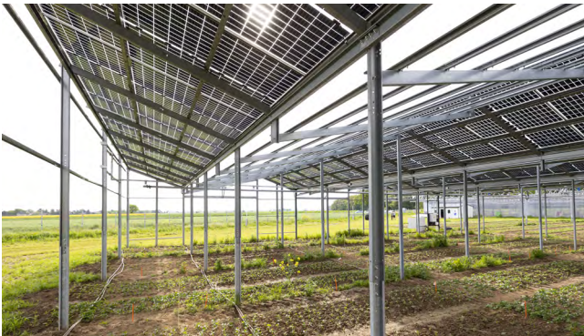
Fig. 47 - Dual land use for agriculture and photovoltaics (© Forschungszentrum Jülich / Sascha Kreklau)
